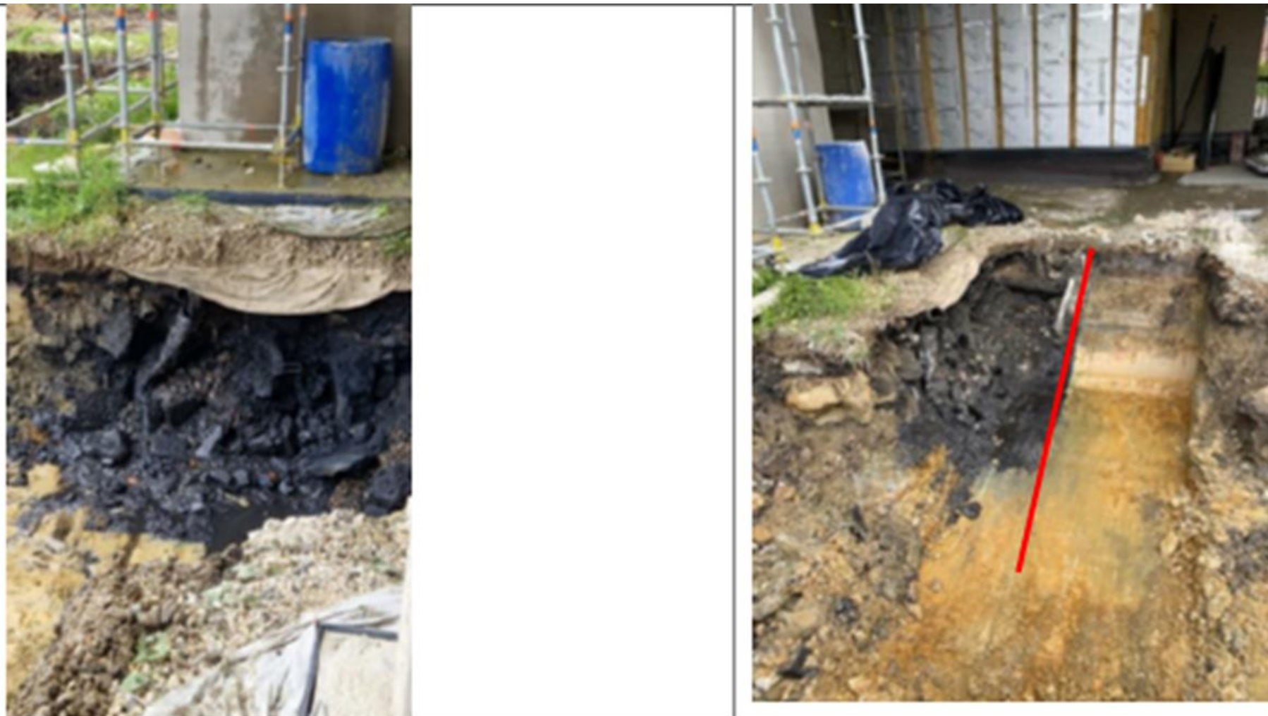
Photo 7 : ZC5 - structure arrondie et mur en béton autour de la citerne éventuelle
